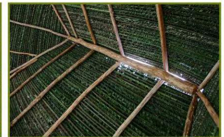
Foto 8. Detalle constructivo del techo, vista inferior
