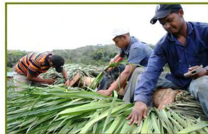
Foto 7. Proceso de construcción de caneyes
