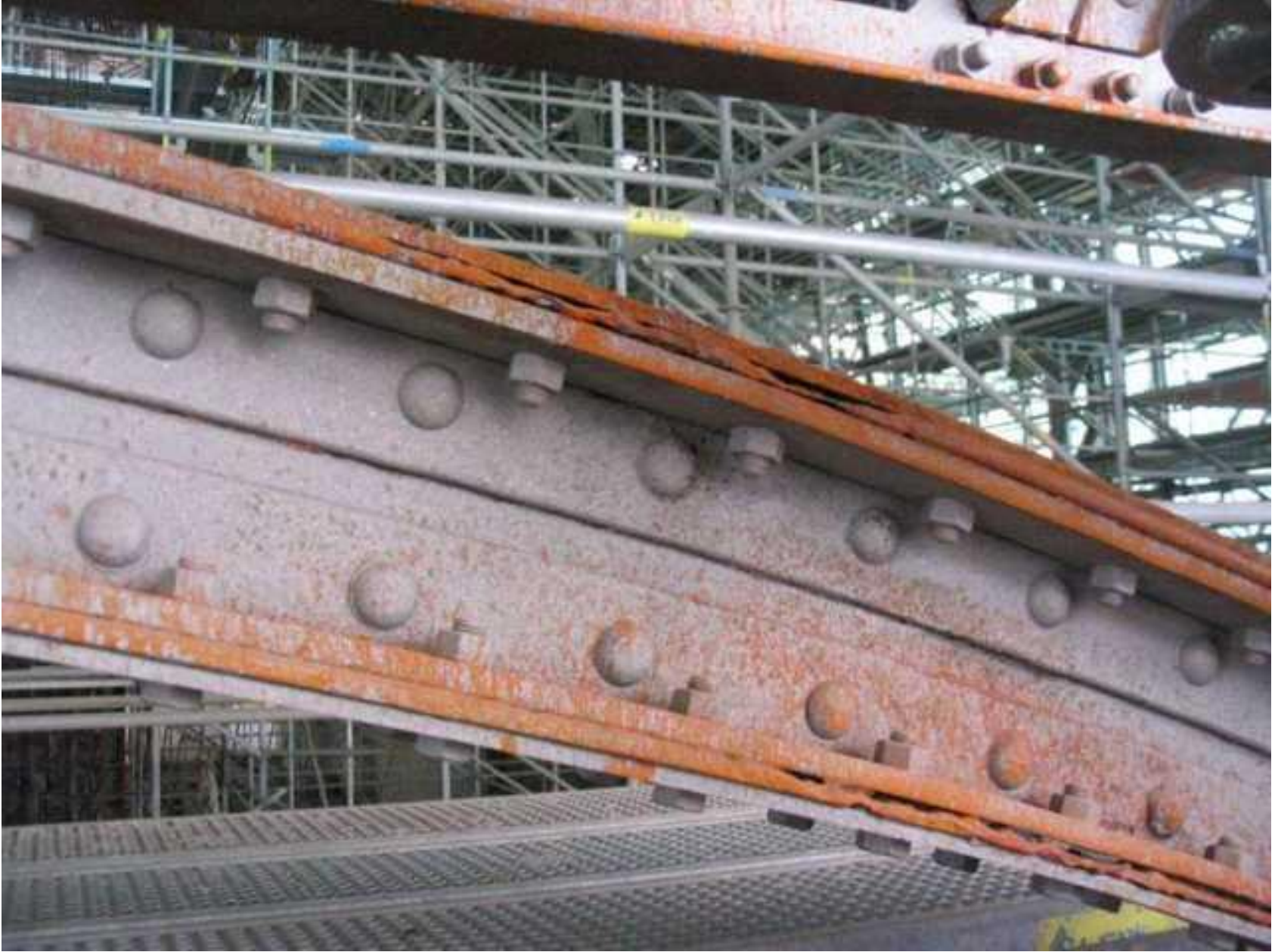
Domages dus à la corrosion sur des éléments de construction statiques
