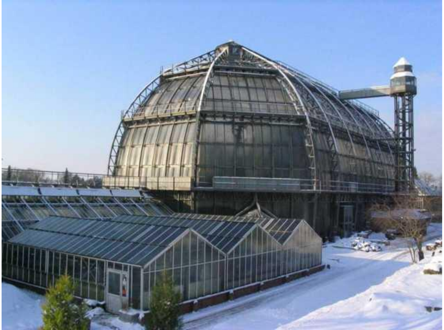
Façade en acrylique surbaissée (épaisseur du matériau acrylique 6mm) 1963 - 2006
