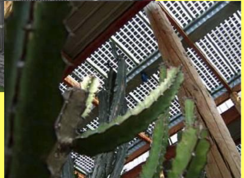
Jardins Botaniques de Bordeaux – 37 kWc modules monocristallins semi-transparents
