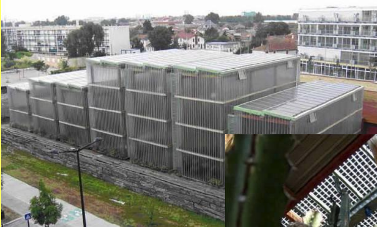
Jardins Botaniques de Bordeaux – 37 kWc modules monocristallins semi-transparents
