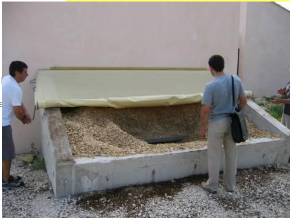
Silo aérien équipé d'une trémie de déchargement et d'une vis de relevage Cabrières d'Avignon (84)
