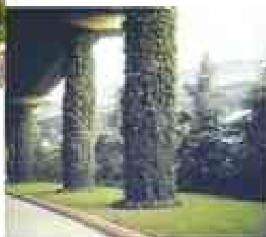
高架路立柱绿化
